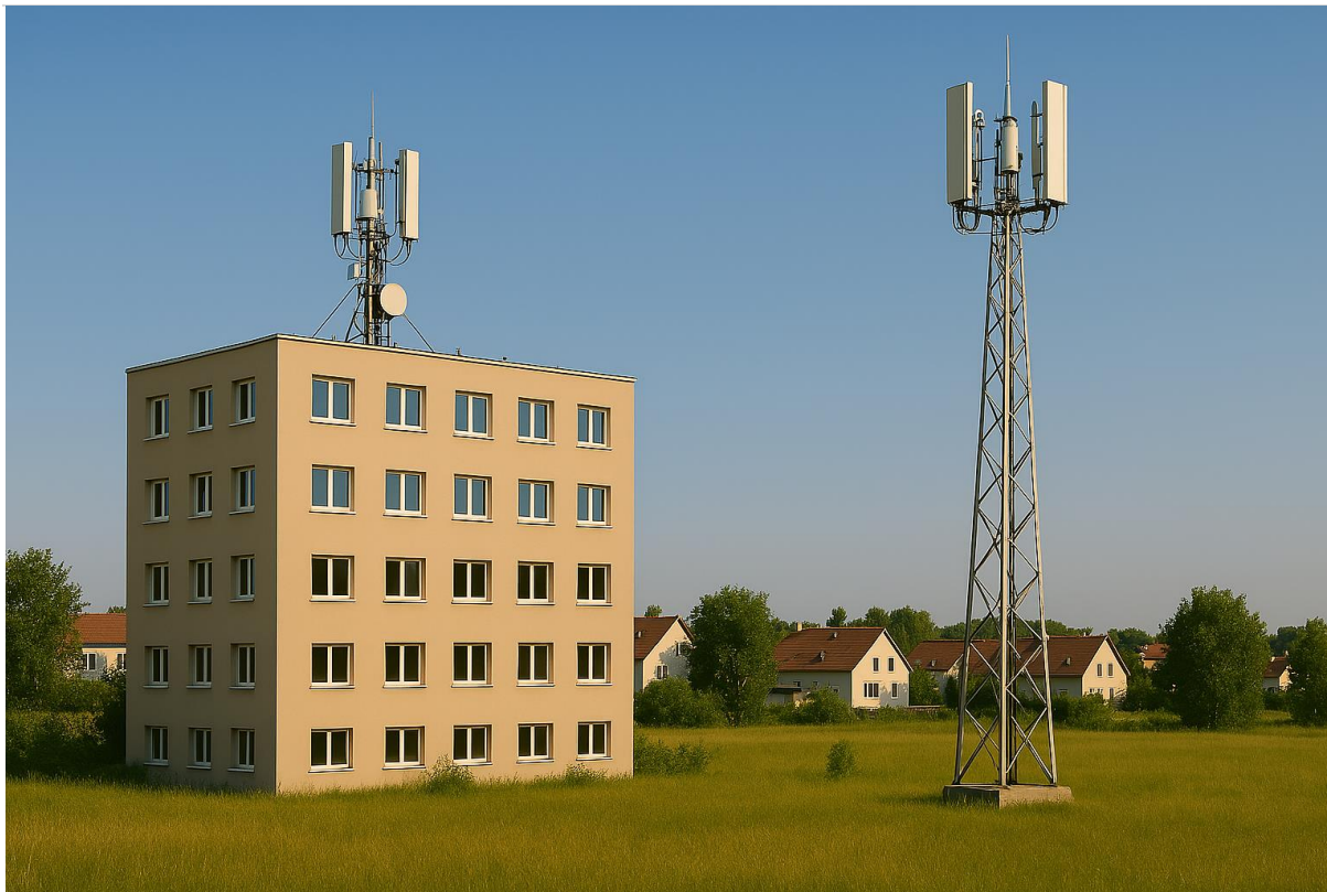
Rysunek 4. Stacje bazowe telefonii komórkowej: zainstalowana na dachu budynku oraz wolnostojąca Źródło: opracowanie własne
